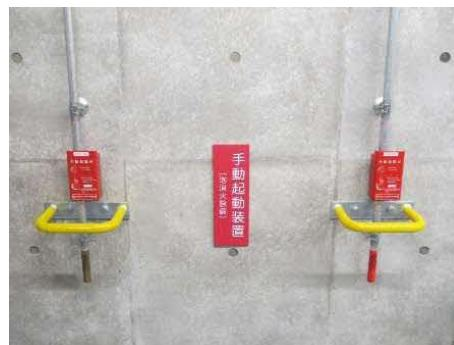
手動起動装置に保護ガードを設置
